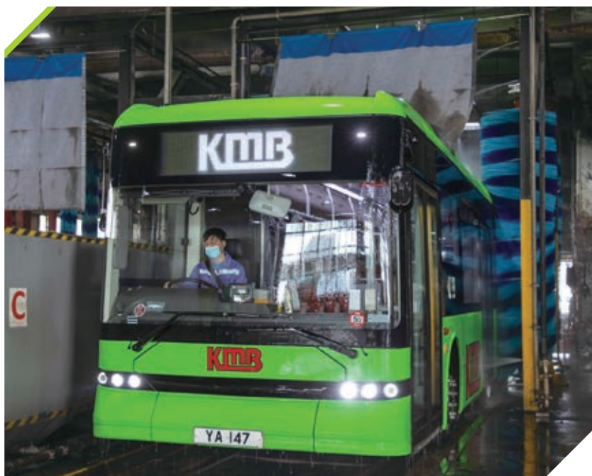
▲ 巴士車廠的污水處理及水循環系統採用環保設計，能有效減低用水量
